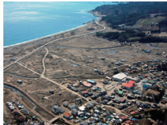
被災後の城内地区空撮
