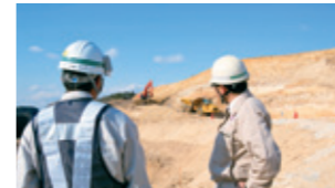
各地で大規模な工事が進む(東松島市)
