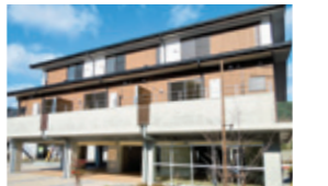
平成25年11月に完成した大槌町屋敷前地区の災害公営住宅
