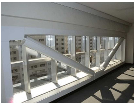
エレベーターホール内の補強
