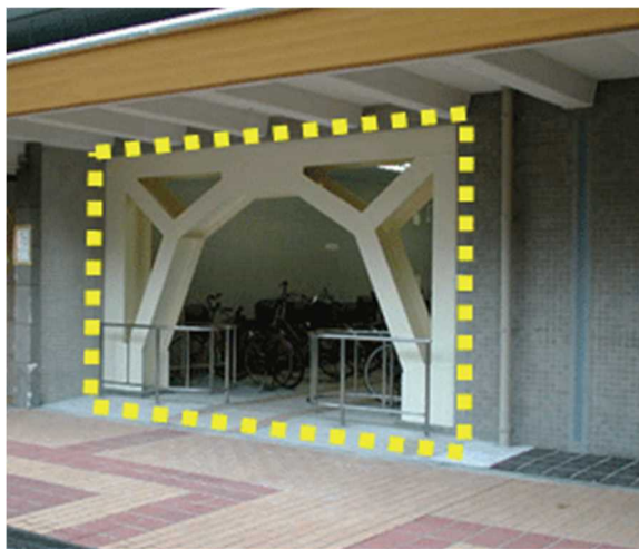
鉄骨ブレース（破線部分）
