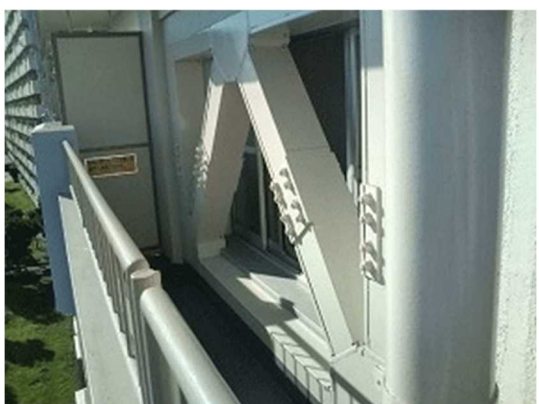
住戸バルコニー側の補強
