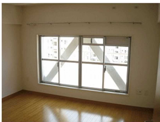
住戸バルコニー側の補強（室内から）
