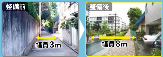
北側・東側道路の拡幅 (幅員 3→8m コミュニティ道路)
