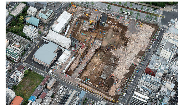
四谷駅前地区(市街地再開発事業) 機構施行により建築中の再開発建物
