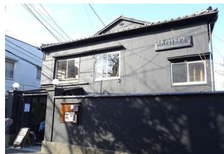
HAGISO ：昭和30年代の木造賃貸アパートをカフェとギャラリーとスタジオに改装し再生活用している。ホテルプロジェクト“HANARE”のフロントも設置している。当日は懇親会の会場としてカフェを利用した。
