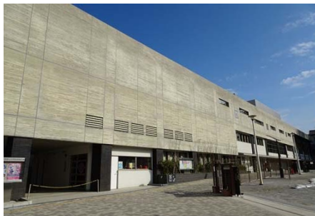
防災関連施設「谷中防災コミュニティセンター」 ：既存のコミュニティーセンターを建替え整備、隣接する防災広場に開放できるよう計画され、一体的に使用可能。
