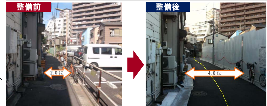
区画道路1号の拡幅整備
