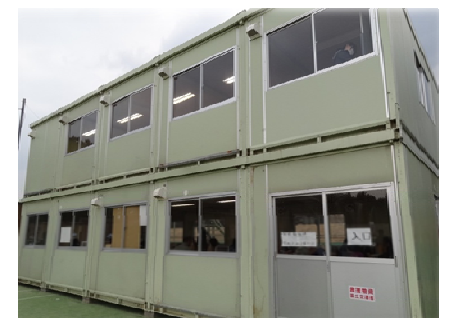
テニスコートに建てられた役所仮庁舎
