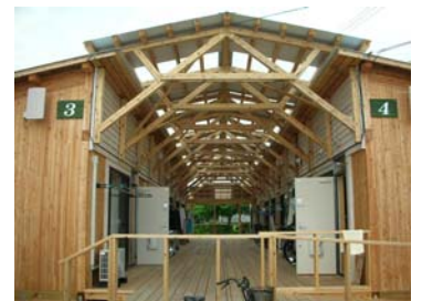
ウッドデッキのある木造仮設
