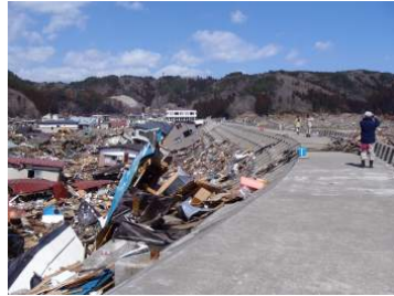
UR 現地調査による被災状況写真
