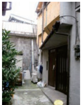
整備前:崖地にぶつかり行き止まりになった通路
