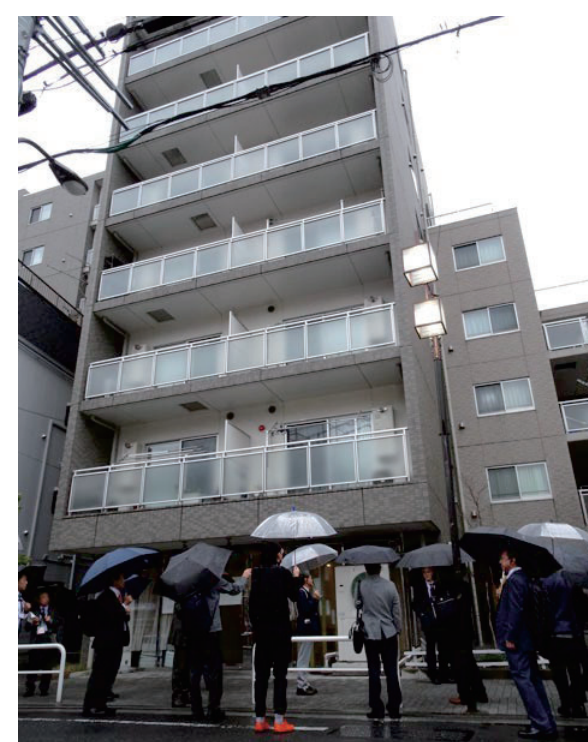
若葉3-2地区:当初の共同建替えモデル地区の1つ。事業が難航し区域を縮小して実現したが、後に隣接地区への共同建替えの連鎖につながった。
