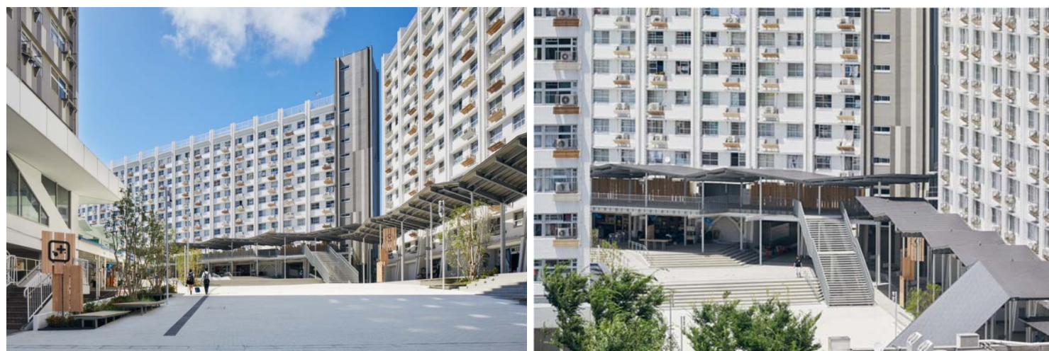
洋光台中央 広場の様子 改修後
