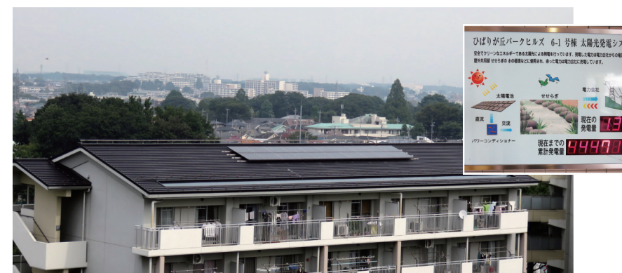
屋上に設置された太陽光パネル
