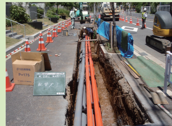
電線地中化工事（バス通り）
