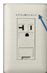
専用回路のエアコン用コンセント (15・20A 100V)
