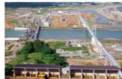
大量の土の搬出のため設置されたベルトコンベヤー(岩手県陸前高田市)
