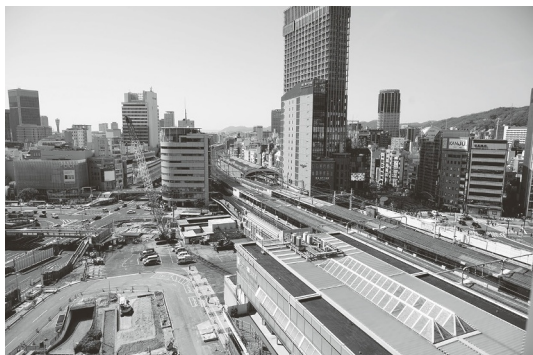
左は未来のJR三ノ宮新駅ビル。右は現在、新駅ビルを建設中の工事ヤード。
