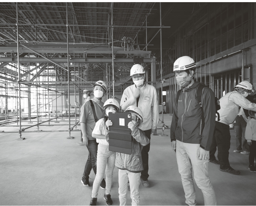
着々と進む工事現場を見学する親子。完成した内部の様子をMRでも体験。
