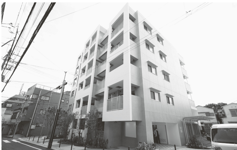
入居が始まった従前居住者用賃貸住宅「コンフォール品川西大井」
