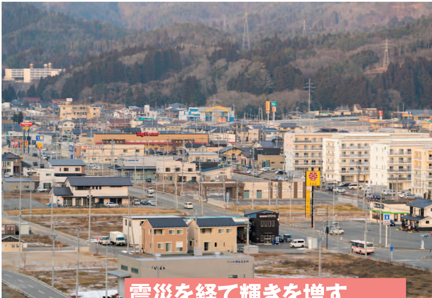
住宅や商業施設が次々に建設され、活気にあふれる鹿折地区。
