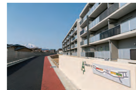
5 岩手県盛岡市 県営南青山アパート
