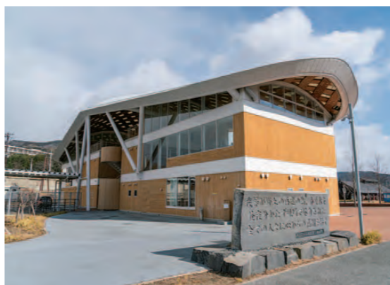
7~9mもかさ上げして造られたJR女川駅。2階には町営の女川温泉「ゆぼっぼ」も併設。
