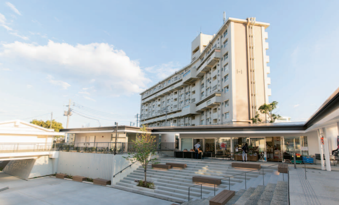
従来のサンクンガーデン(半地下の広場)を生かして改修した集会所まわり。写真の正面右がコミュニティーカフェ「よっしーのお芋屋さん」。手前と左側に集会所があり、階段下の左側から奥の広場へつながっている。
