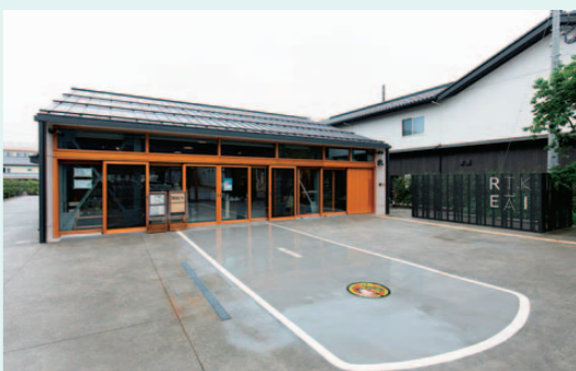
建物前の広場の地下は防火水槽。広場では、毎週土曜の午前中にミニマーケット「土曜キタ市」を開催。周辺の商店にも人が流れ、いい関係が生まれている。
