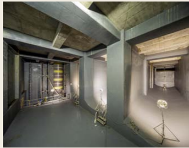
雨水貯留施設の内部
