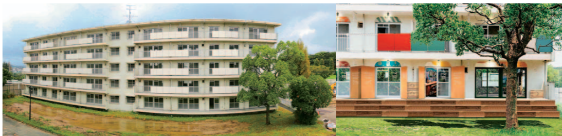
再生地区と地域を結び、誰もが気軽に訪れやすい場所に位置する48号棟。リノベーション前の外観。
