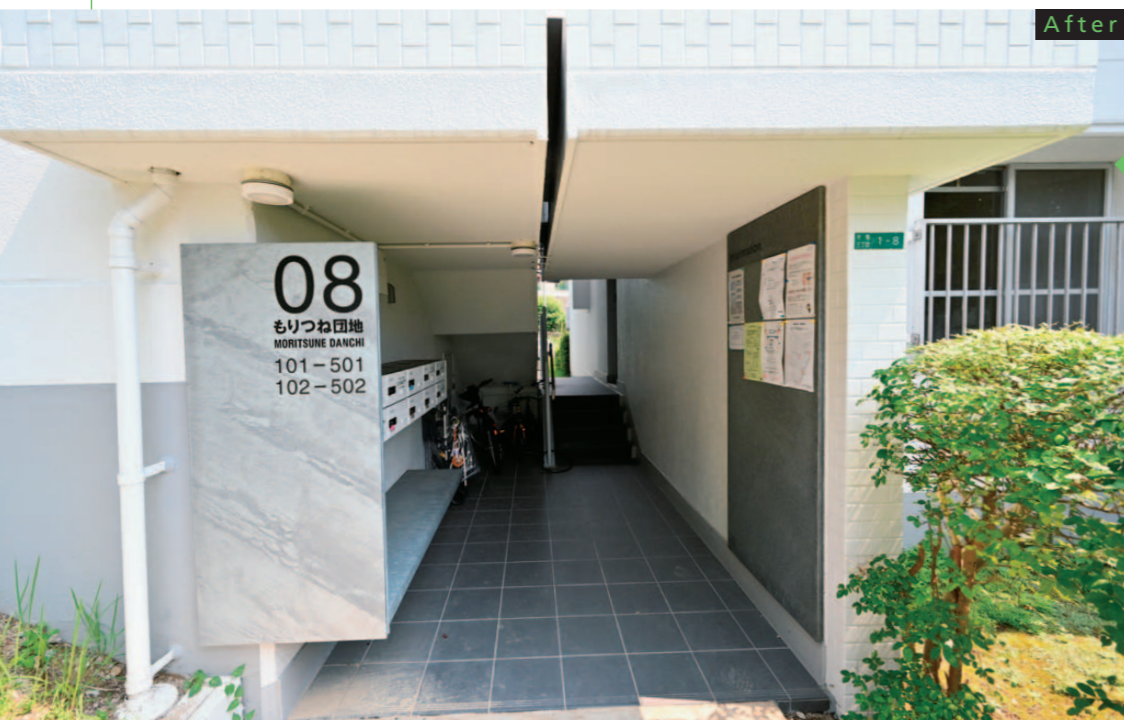
エントランスには号棟と、各階段室の対象号室がわかるサイン入り雨除けスクリーンを設置。照明と荷物置台も新設され、安全性と利用しやすさを向上。
