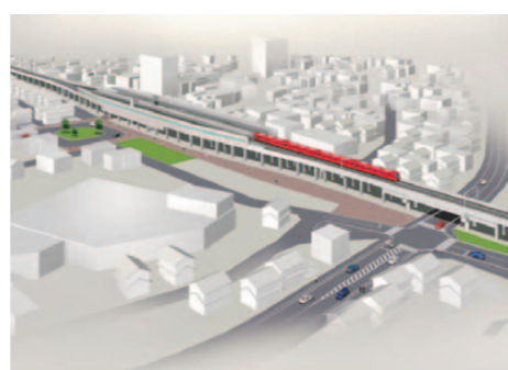
北側から新清洲駅を望む完成イメージ。鉄道を高架にして踏切渋滞を解消し、交通の利便性を高める。出典：「名鉄名古屋本線新清洲駅付近鉄道高架事業パンフレット」国土交通省中部地方整備局/愛知県
