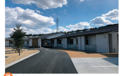
7 福島県大熊町 大川原地区福祉施設
