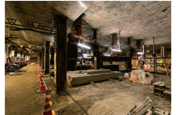
上/およそ50年前に完成した構造物である日比谷線の直下を掘削して建造物を新設するため、既設建造物に影響を与えない工法を採用した。2020年2月撮影。
