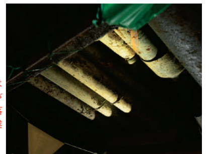
上/およそ50年前に完成した構造物である日比谷線の直下を掘削して建造物を新設するため、既設建造物に影響を与えない工法を採用した。2020年2月撮影。
