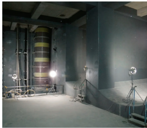
水害に強いまちを目指して工事が進む地下貯留槽。貯まった雨水は天候の回復後、48時間かけて下水に放流される。右図は水が貯まったときのイメージ。
