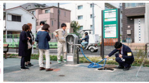
上／都営アパートの跡地につくられた川島公園。防災パーゴラ、防災倉庫、ソーラー式照明灯、ソーラー時計などが備えられている。右／園内には防災井戸もあり、汲み上げた水をマンホールトイレの貯水槽につなげられる仕組み。左／マンホールトイレ用のトイレントを設置するための固定アンカーも装備されている。
