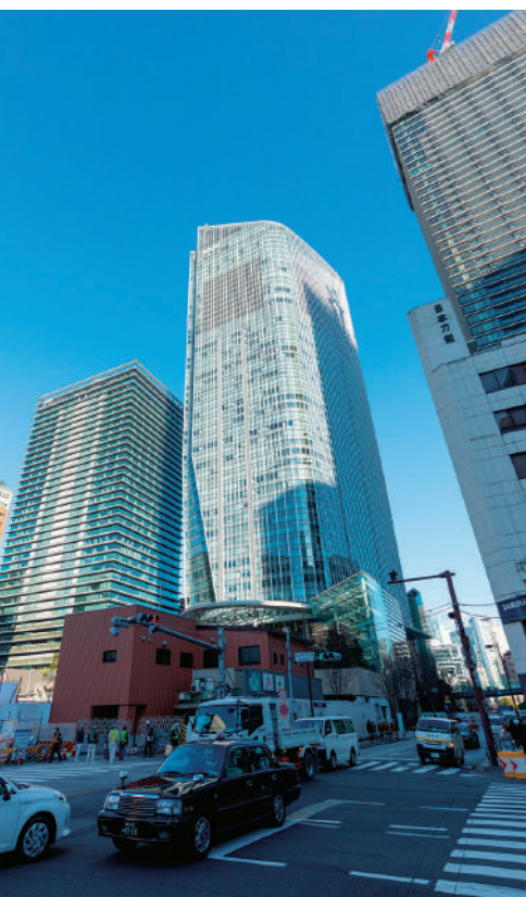
交通量の多い虎ノ門の地下で工事は着々と進む。中央は虎ノ門ヒルズ。その手前にある茶色の建物が「虎ノ門ヒルズ駅」の入り口になる。
