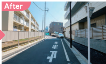
建物を取り壊され、新たに道路が整備された。通り抜けが可能となり、防災性と利便性が高まった。
