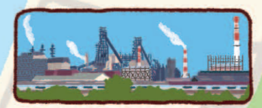
ペDESTリアンデッキの先端から対岸を見ると、間近に日本製鉄八幡製鉄所小倉地区の工場群が!
