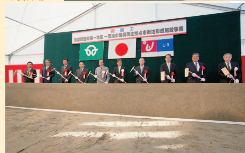
下／工事の安全祈願の後、田中復興大臣らによる鉄入れも行われた。
