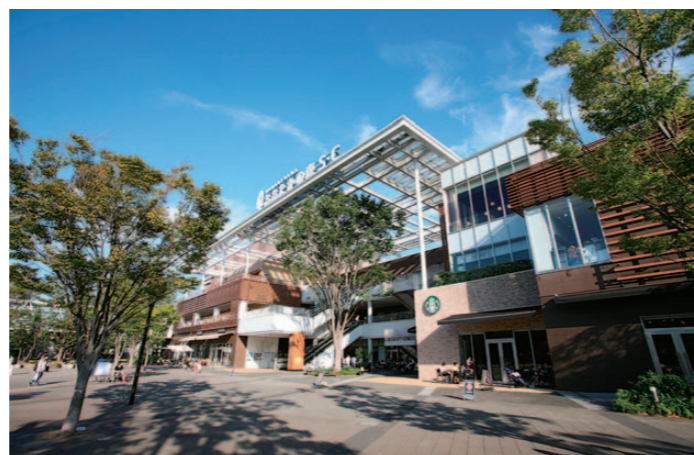
流山おおたかの森駅南口に隣接して、高島屋をキーテナントとする大規模商業施設「流山おおたかの森S・C」が誕生した。
