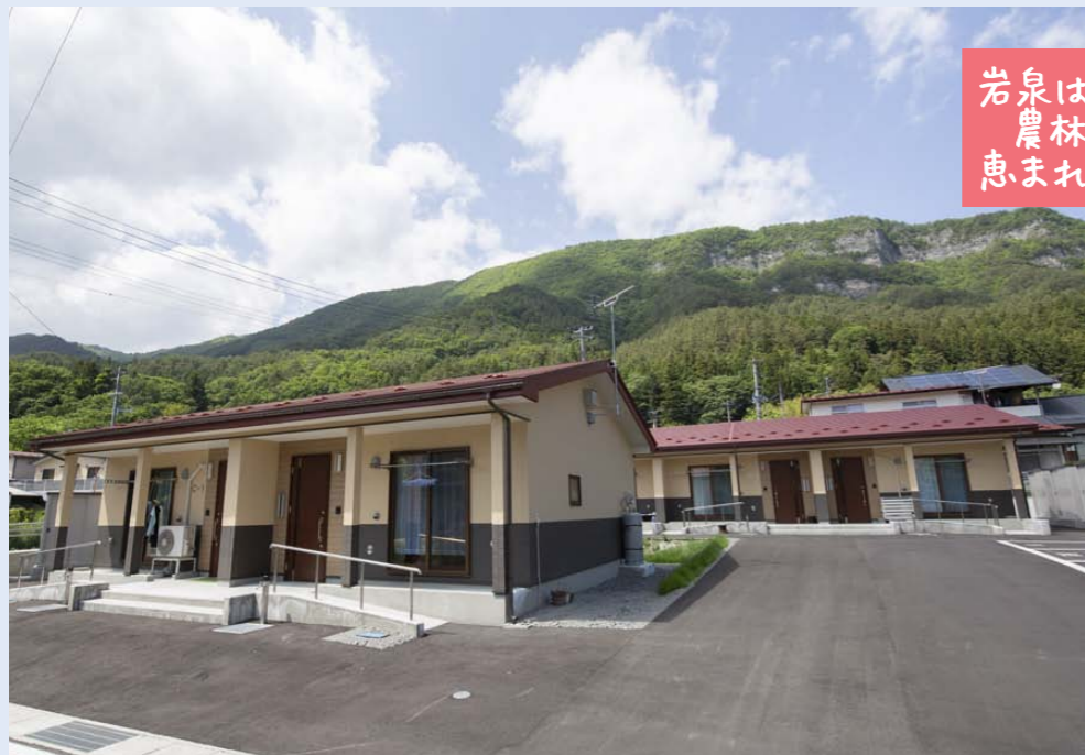
災害公営住宅は63戸。URは復興まちづくりを事業情報の提供や、考え方への助言などで支援。建物の建設は岩泉町で行った。
