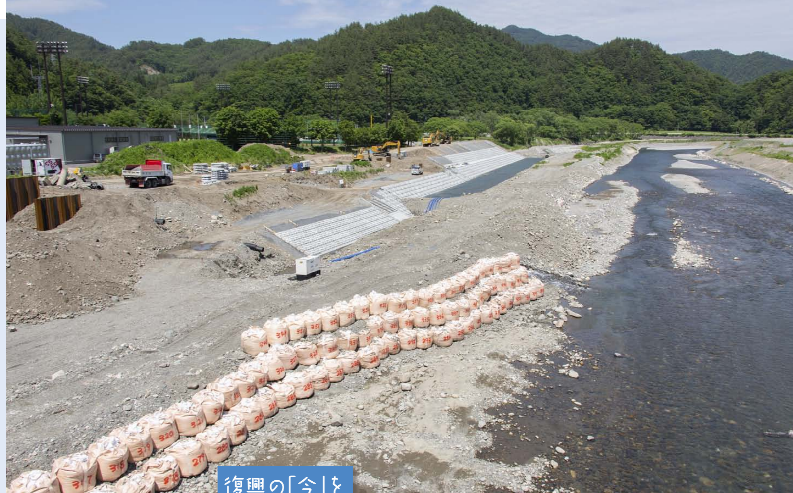
激しい雨の増加と水位の急上昇によって、堤防を越えた岩泉町の小本(おもと)川。河道の掘削や築堤、護岸、橋梁の架け替えなど、復旧・復興作業が続く。
