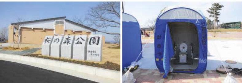
災害時は復旧拠点になる備蓄倉庫(下左写真)と、災害用マンホールトイレ(下右)。
