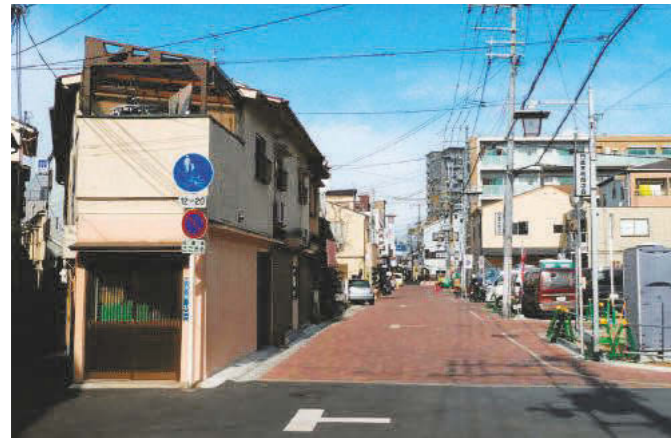
防災道路を拡幅(約3m→6.7m)し、アースカラーに変更。上は拡幅前、下は拡幅整備後。
