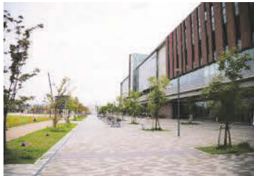
右側が「フューチャープラザ」。1階にはカフェとレストランも入っている。
