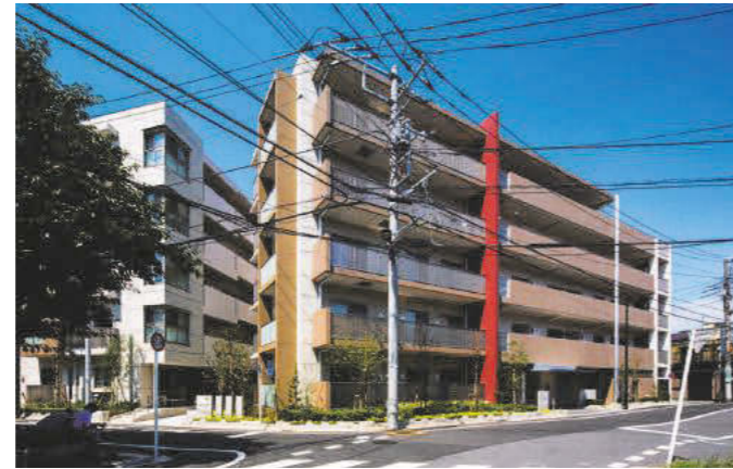
下/URが整備した防災施設を備えた共同住宅。
