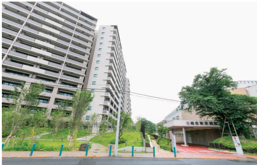
総戸数531戸の分譲マンション「グランドメゾン江古田の杜」(左)のすぐ横に、総合東京病院の新棟(右)が建つ。賃貸住宅の敷地内には医療従事者用のマンションもあり、災害時にも迅速な対応が可能。
