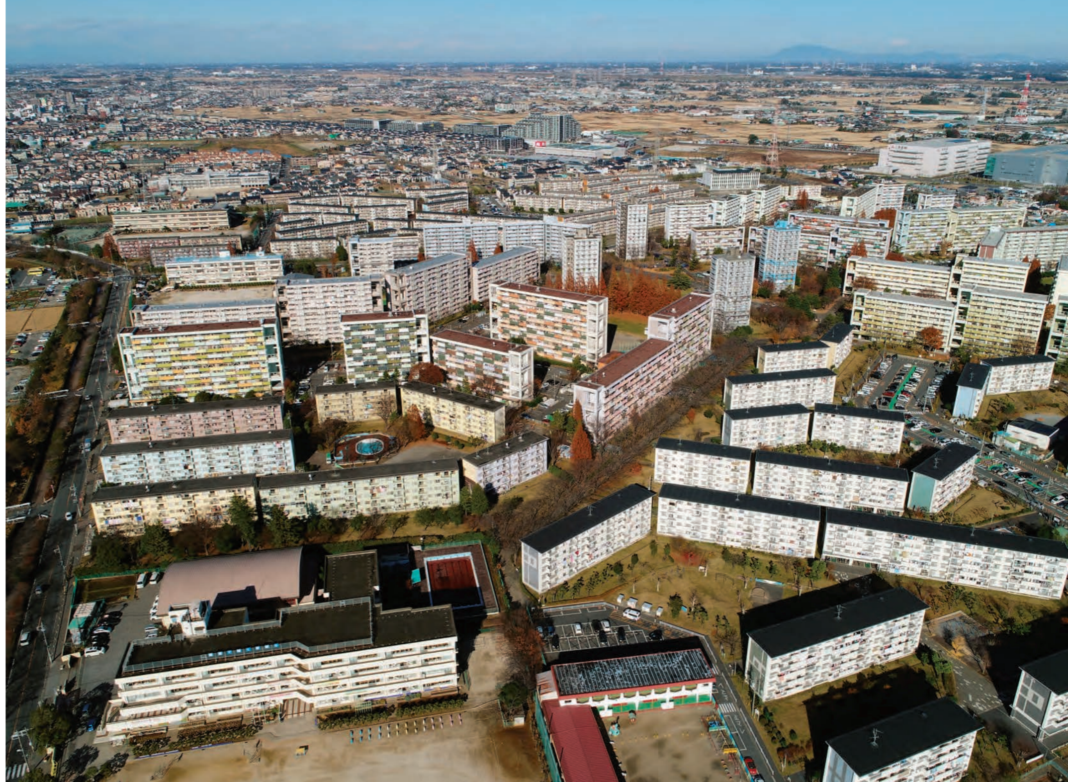
1万人以上の人々が暮らすみさと団地。外壁修繕が行われており、「MISATO TONE」と呼ばれる色でコーディネートされた住棟が見える。
