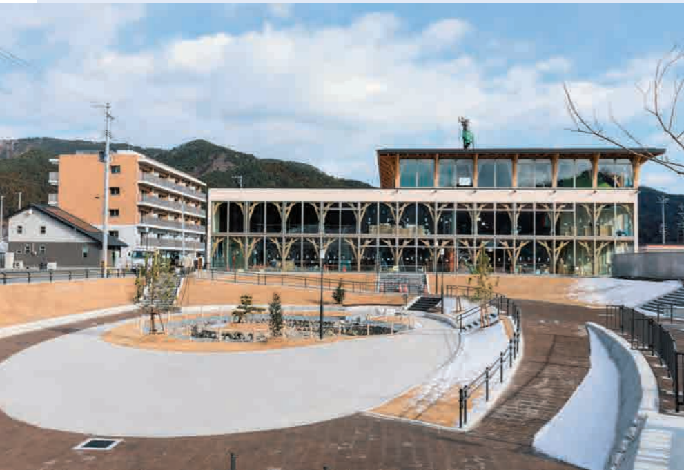
大槌町の歴史的、文化的ランドマークだった御社地を再生。池のほとりには、全国でも珍しい純木造3階建ての図書館や多目的ホールが入った施設を町が建設中(4月にオープン予定)。左には御社地町営住宅が建つ。
