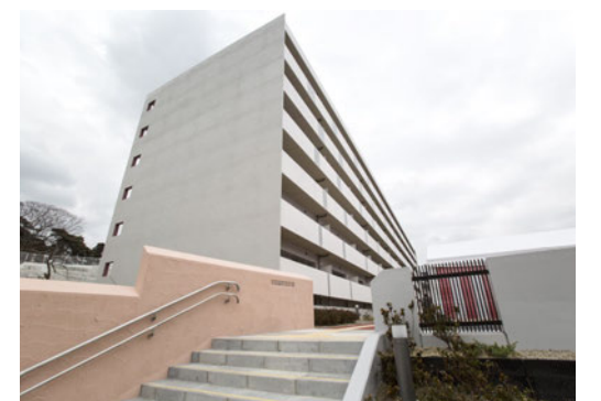
錦町東住宅は全70戸。塩竈桜をイメージしたカラーリングで、エントランスホールを集いの場としてしつらえた。
