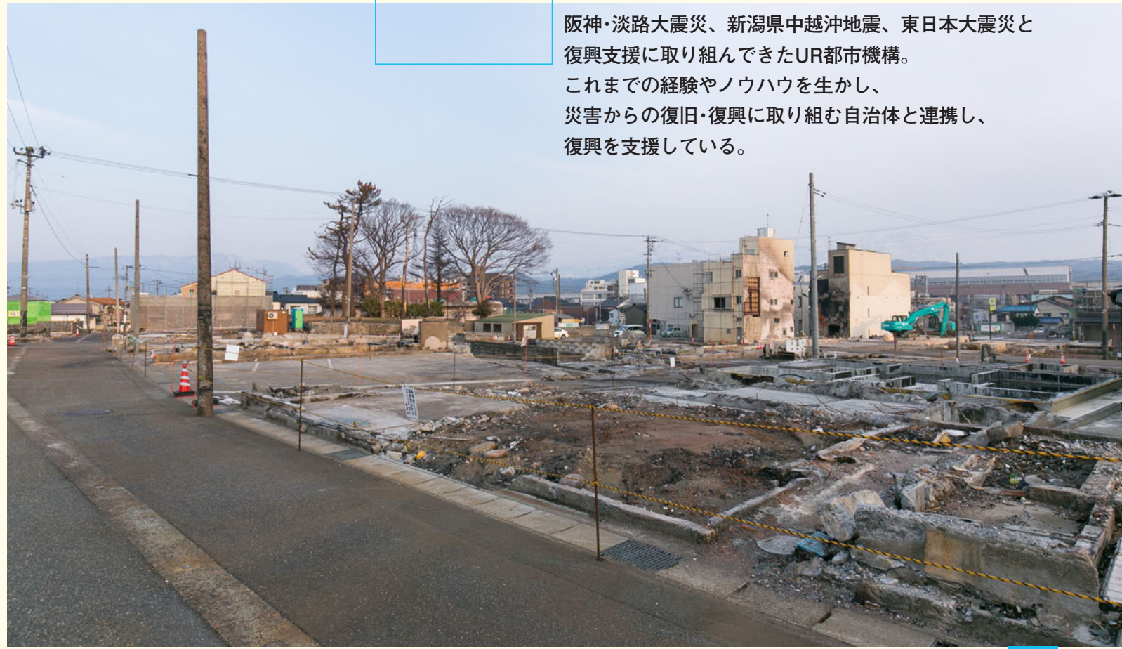
糸魚川駅と日本海の間広がる被災エリア。建物の基礎の撤去作業は夏までに終了予定。道路を拡幅し、「居住」「にぎわい」「商業飲食」の3つのエリアに分けて復興を進める計画だ。
