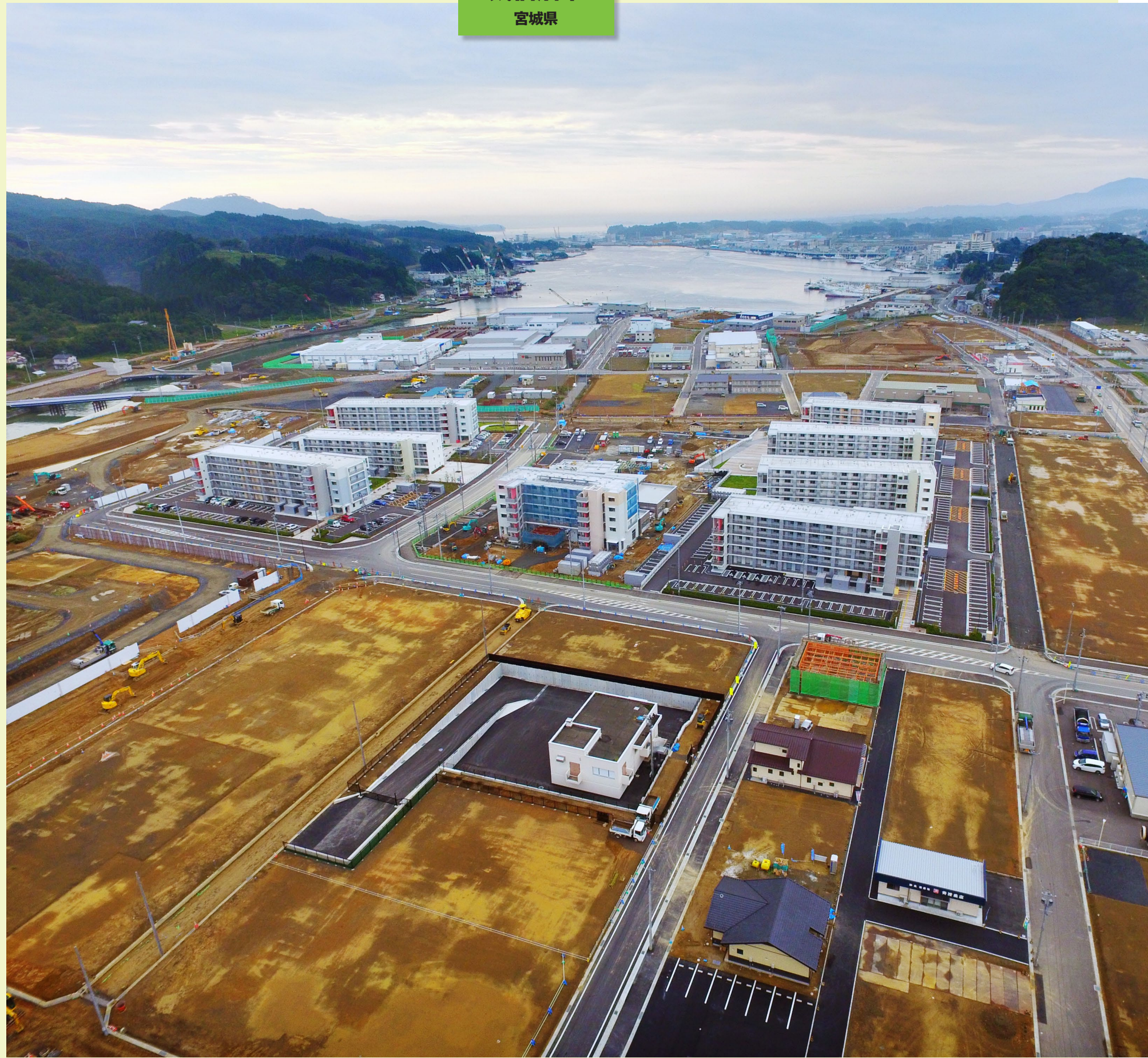
市街地整備が進む気仙沼の鹿折地区。中央に立ち並ぶ鹿折南災害公営住宅が、復興のシンボルになっている。
