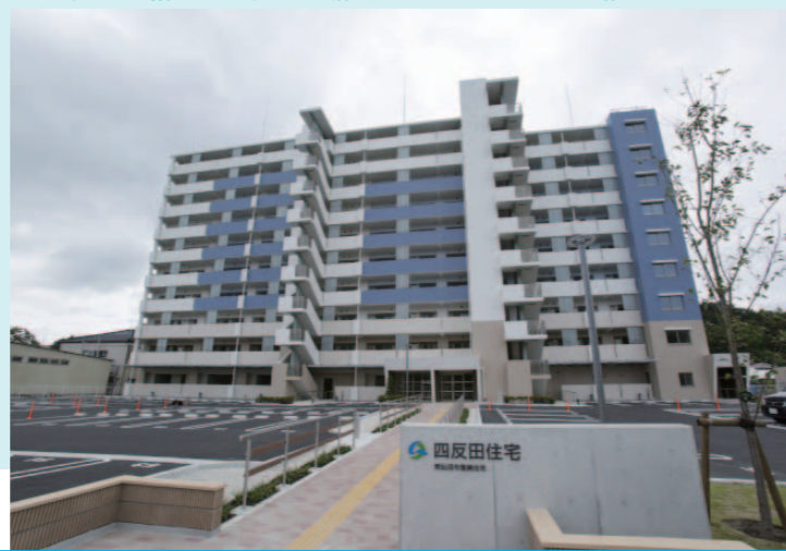
四反田住宅は10階建て全70戸。空に溶け込むブルーをアクセントに配した。
