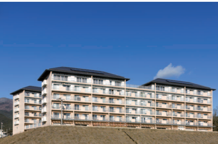
岩手県陸前高田市に完成した下和野団地(災害公営住宅)。
