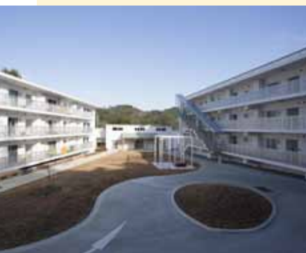
町営入谷復興住宅は42戸。2棟を斜めに配置している。
