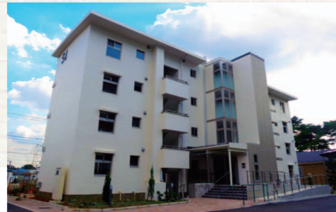
既存住棟を改修してエレベーターを設置した、サービス付高齢者向け住宅。
