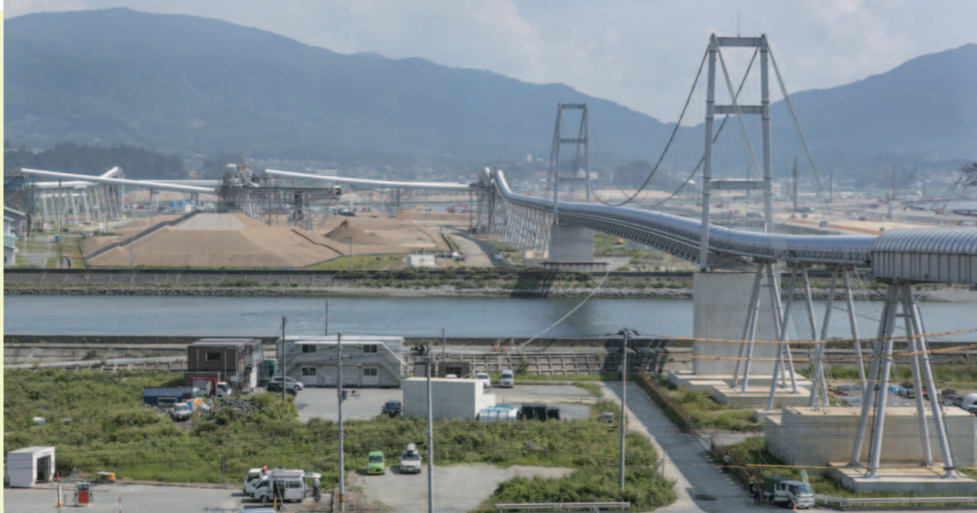
「希望のかけ橋」と呼ばれるベルトコンベヤーが、川を渡り旧市街地に向かって延びている。「動く歩道」と間違える人も多いとか。山から削り出した土砂や岩を30cm以下まで破砕して搬送。日々、大量の土砂が積み上げられている。
