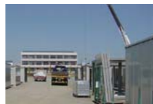
いわきニュータウンに建設された応急仮設住宅
