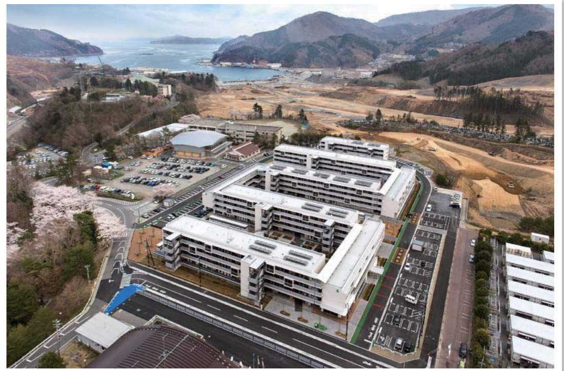
宮城県女川町では2014年3月、女川湾を望む高台に災害公営住宅(女川町営運動公園住宅、200戸)が完成した。隣接する仮設住宅(写真：右下)などから、被災された方々が引っ越して新たなコミュニティが生まれつつある。被災した市街地(写真：奥)では、復興市街地整備事業の造成工事が進んでいる
