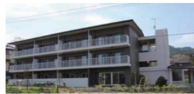
大船渡市平林地区の災害公営住宅
