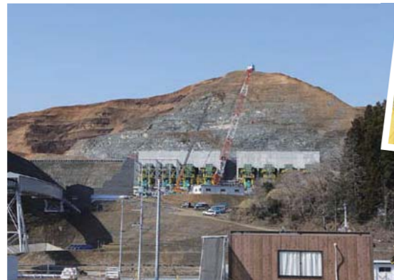
山を最大80mほど切り崩し、高台に住宅地を造る(上)。切り出された岩石と土砂は、直径30cm以下に砕かれ、ベルトコンベヤーで気仙川対岸の旧市街地にまで運ばれる(右上と左)。現場では背丈より大きな車輪を持つ50t積みの巨大なダンパーが活躍する(右)
