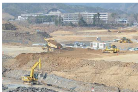
来年3月完成予定のJR女川駅を中心に、急ピッチで造成中の市街地
