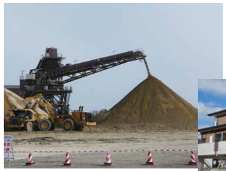
東松島市野蒜北部丘陵地区では土砂運搬用ベルトコンベヤーで工事を迅速化
