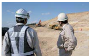
各地で大規模な工事が進む(東松島市)
