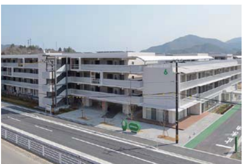
3月に完成した町営運動公園住宅。8棟構成で建物の間に中庭を持つ
