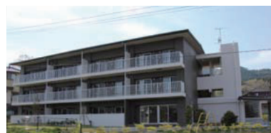
大船渡市平林地区の災害公営住宅
