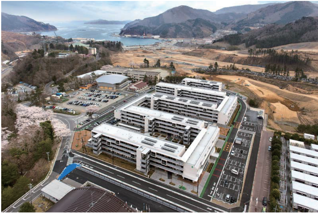
宮城県女川町では2014年3月、女川湾を望む高台に災害公営住宅(女川町営運動公園住宅、200戸)が完成した。隣接する仮設住宅(写真:右下)などから、被災された方々が引っ越して新たなコミュニティーが生まれつつある。被災した市街地(写真:奥)では、復興市街地整備事業の造成工事が進んでいる
