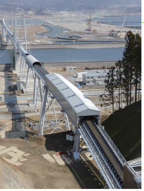
山を最大80mほど切り崩し、高台に住宅地を造る(上)。切り出された岩石と土砂は、直径30cm以下に砕かれ、ベルトコンベヤーで気仙川対岸の旧市街地にまで運ばれる(右上と左)。現場では背丈より大きな車輪を持つ50t積みの巨大なダンパーが活躍する(右)
