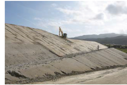
高田地区で実施した試験盛土。安全性の検証と宅地完成の前倒しという2つの目的があった
