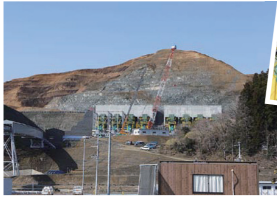
山を最大80mほど切り崩し、高台に住宅地を造る(上)。切り出された岩石と土砂は、直径30cm以下に砕かれ、ベルトコンベヤーで気仙川対岸の旧市街地にまで運ばれる(右上と左)。現場では背丈より大きな車輪を持つ50t積みの巨大なダンパーが活躍する(右)
