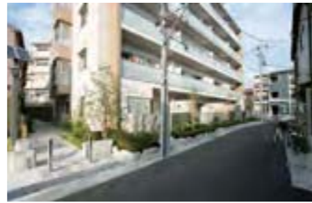
防災街区整備事業によって道幅2mから4mに広げられた建物南側の道路
