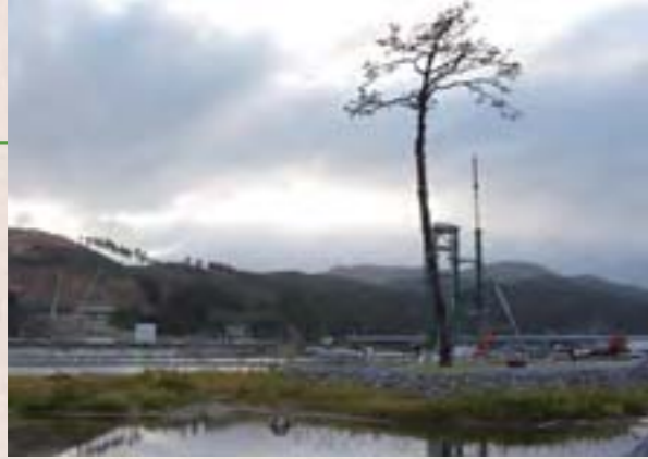
希望の象徴として再生・保存された「奇跡の一本松」。その奥で、大量の土を山から平地部に迅速に運ぶためのベルトコンベヤーの建設工事が急ピッチで進む
