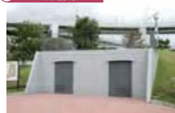
⑤ 備蓄倉庫
