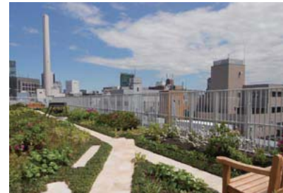
アーベインビオ川崎(川崎・幸区、写真上)やシャレール恵比寿(東京・渋谷区、写真下)のように、遊歩道を設けたり、遊具を設置して公園のような設計にした屋上緑化もある
