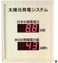
エレベーターホールには、発電量を知らせる表示板がある(シャレール荻窪)
