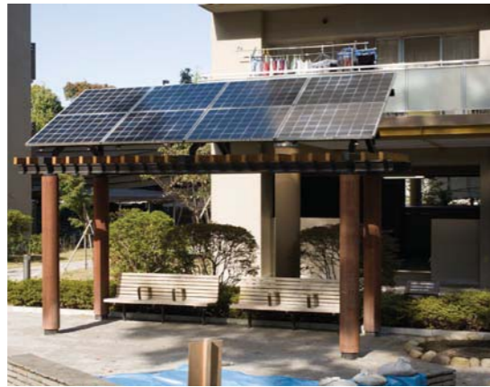
多摩平の森(東京・日野市)では施設内の東屋(あずまや)の屋根にパネルを設置して雨水の循環システムに活用している
