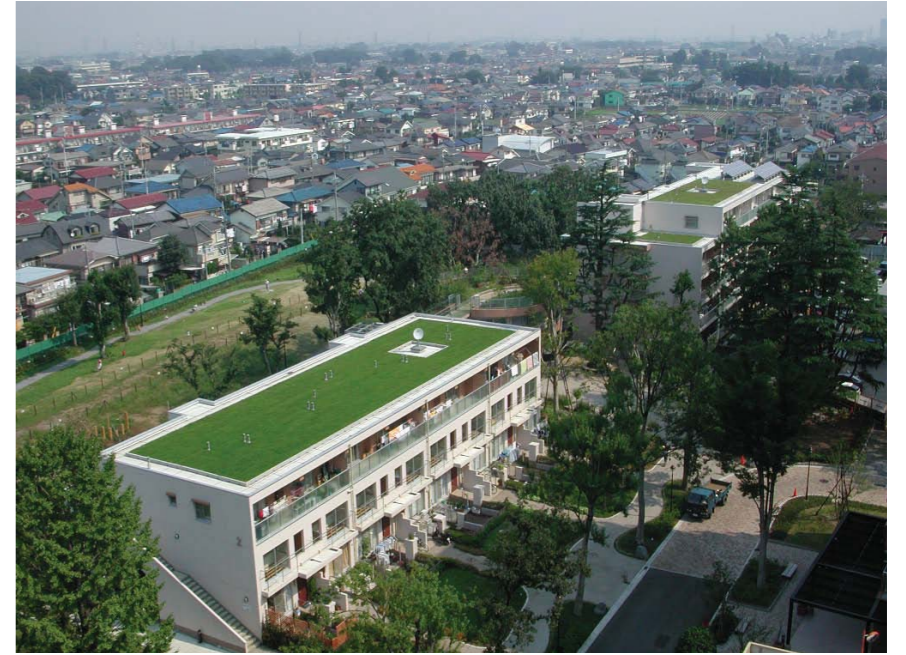
周辺に住宅が立ち並ぶグリーンプラザひばりが丘南では、屋上緑化でヒートアイランド現象の抑制を図っている
