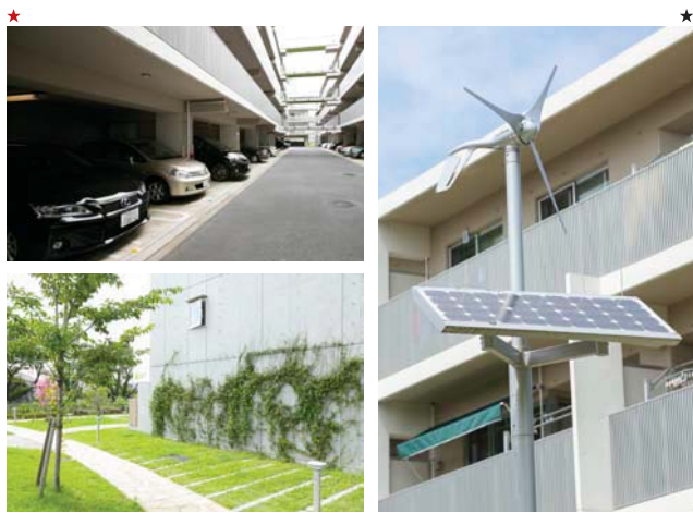
風車と太陽光発電パネルによる電気を街灯などに活用。駐車場を建物1階に入れて、敷地内のコンクリートで覆われた面積を減らしたり、壁面緑化や屋上緑化を取り入れたりすることでヒートアイランド現象の軽減に貢献している
