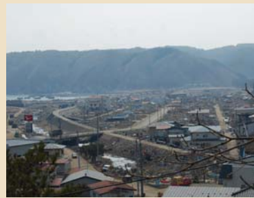
田老(たろう)地区のX字型に組み合わされ2重に設けられた防潮堤。今回の津波はその防潮堤をも乗り越えた
