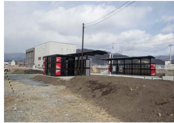
駅舎が大きな被害を受けたJR大船渡駅は、復興の第一歩としてBRT(バス高速輸送システム)の停留所として活用されている
