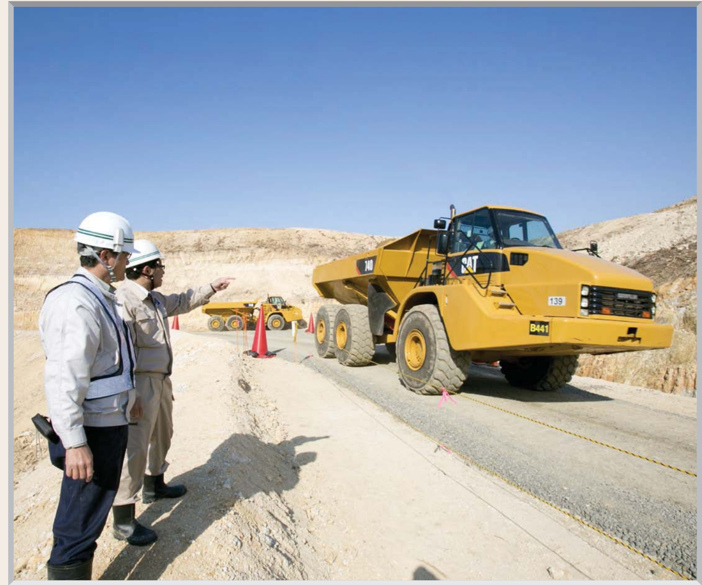
(宮城県東松島市の野蒜北部丘陵地区、写真: 的野弘路)
