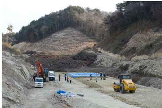
山を切り崩した土は低地のかさ上げに利用する。強固な地盤にするためローラーで固める
