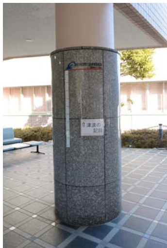
津波は海拔16mほどの高台に立地する当時の町立病院（現女川町地域医療センター）1階まで押し寄せた。エントランス前の柱にはその記録が刻まれている
