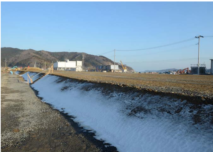
中心市街地の一角、水産加工団地の建設が予定されている区域では、加工施設の建設を秋のさんま漁に間に合わせようと、用地のかさ上げ工事が急ピッチで進む
