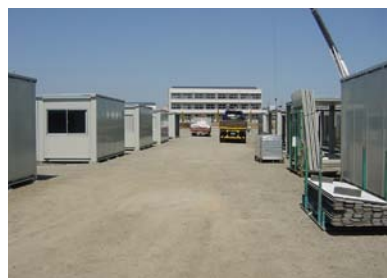
いわきニュータウンに建設された応急仮設住宅
