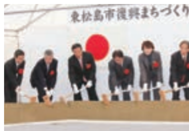
着工式での掘入れ(東松島市)
