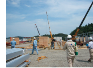
応急仮設住宅中間検査
