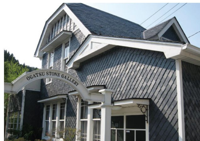
屋根・壁にも雄勝スレートが配された雄勝石ギャラリー。この建物も被災し、現在では土台が残るのみ
