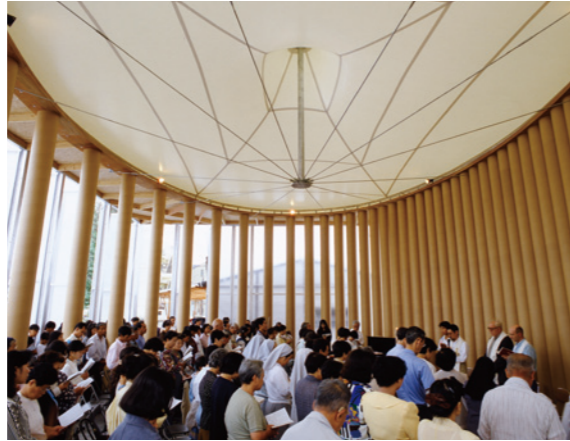
仮設住宅建設の後、紙管を使って建てた神戸たかとり「紙の教会」 ©Hiroyuki Hirai
