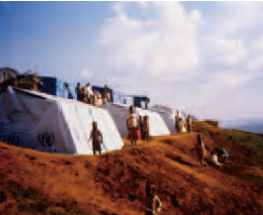
紙管をシートの支柱に使った、ルワンダ難民キャンプの仮設シェルター（UNHCR） ©Shigeru Ban Architects
