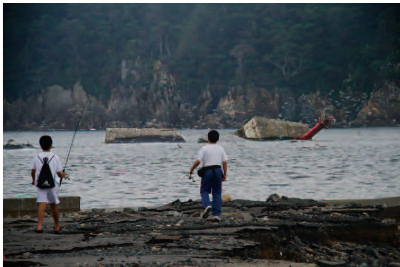
津波で大破した防潮堤を臨む海岸で(岩手県宮古市田老町)
